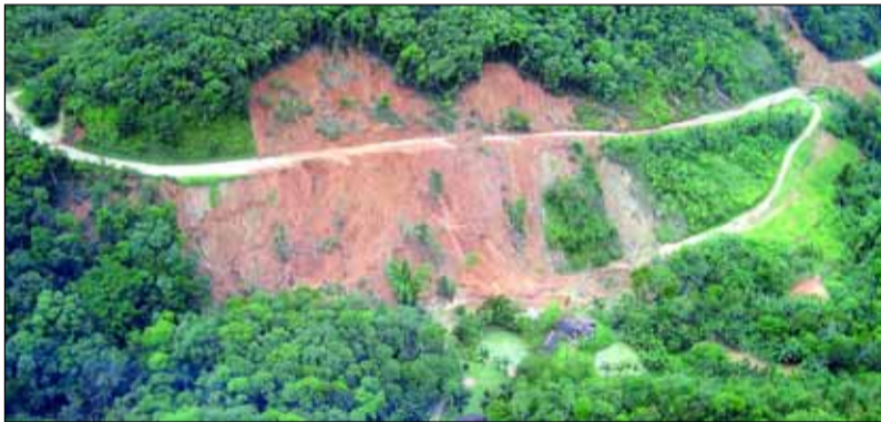
A terra ultrapassou sua capacidade de absorver a água e deslizou como se fosse sorvete
